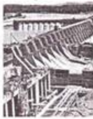
20 世纪 30 年代 美国建设的田纳西水利工程
